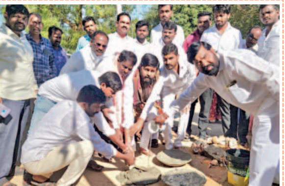
సిసి రోడ్డు నిర్మాణ పనులు ప్రారంభిస్తున్న వారికృష్ణ
