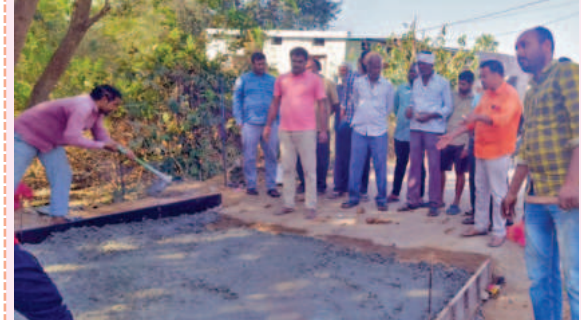
సిీ రోడ్డు నిర్మాణానికి శంకుస్థాపన చేస్తున్న దృశ్యం
